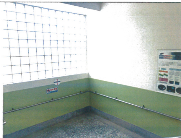
定期粉刷牆壁
