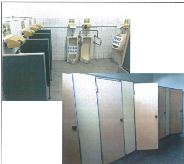
設置足夠的大小便器
