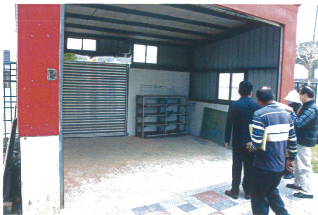
環保屋美化工程-使垃圾車更簡便到學校收垃圾
