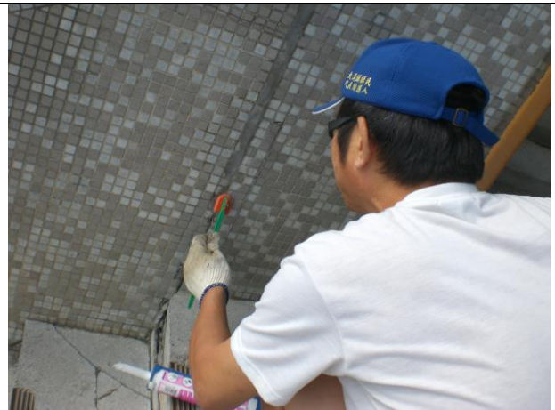
檢查校舍牆壁裂縫並予修繕
