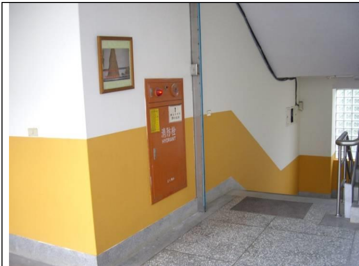
說明：本學期進行校園牆壁油漆換新作業
