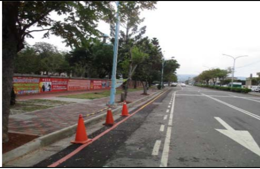
家長接送區車道標線繪設 臺中市立中港高中
