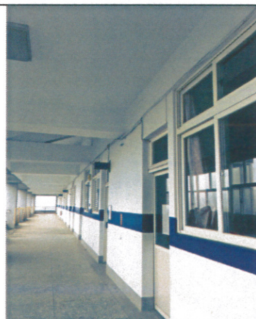
定期粉刷牆壁
